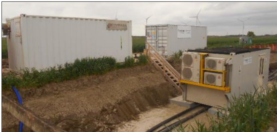
Abbildung 5: Beispielhafte Darstellung eines Muffencontainers zur Herstellung des Kabelverbindingssystems 5
